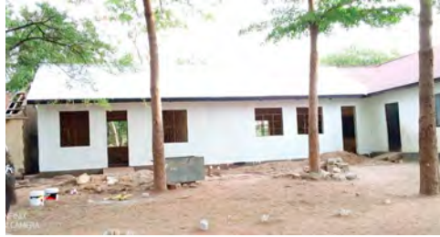
Baufortschritt am Schulgebäude
